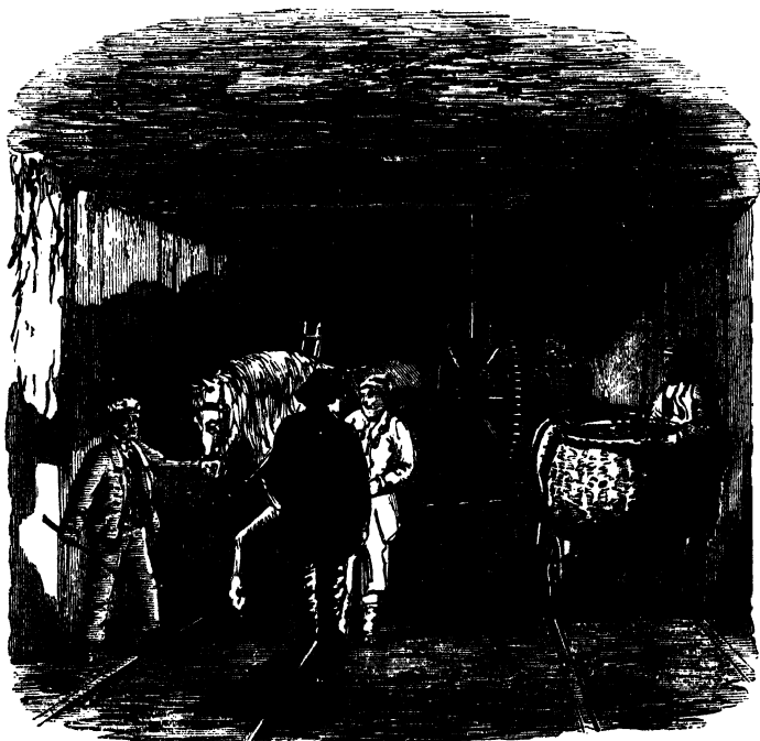
. 48. The Crane Hoister.
